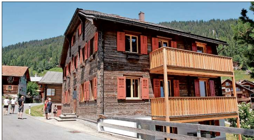
La casa pervenda a Ruschein. FOTO A. BEELI
